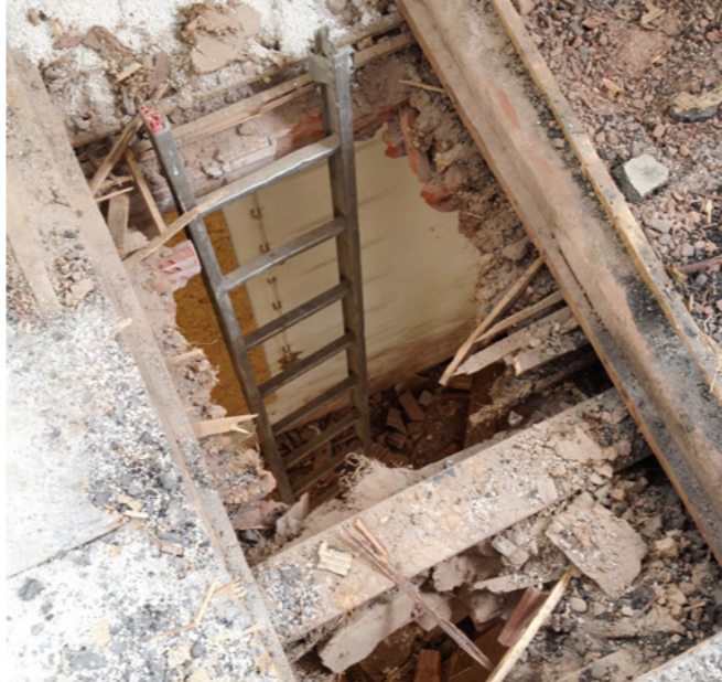
Beginn des Hauptgebäude-Ausbaus 2012 mit dem Durchbruch zwischen Erd- und 1. Obergeschoss
