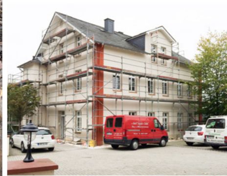
Das zweite EL-Gebäude während des Umbaus 2014...
